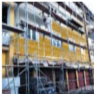
Bis 20 m Gebäudehöhe kann das WDV-System Mineral Lamelle ohne Verdübelung verarbeitet werden.
