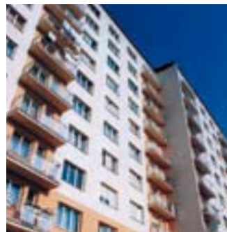
Bis 20 m Gebäudehöhe kann das WDV-System Mineral Lamelle ohne Verdübelung verarbeitet werden.
